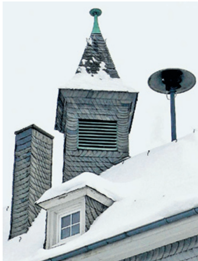
Bömighäuser Dachlandschaft: Schornstein, Gaube, Dachreiter mit Glocke sowie Feuersirene auf der alten Schule. Die Bürger denken über den Bau eines Glockenturms nach. Foto: Ulrike Schiefner
